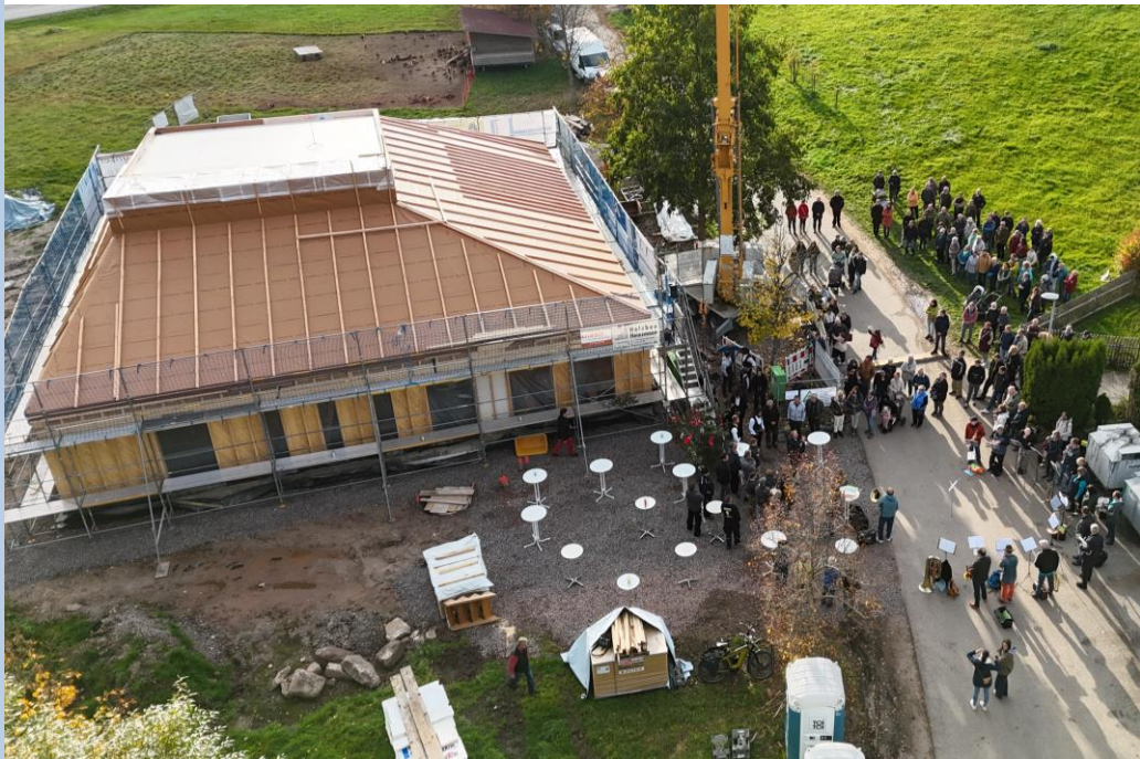
Richtfest auf der Gemeindehaus-Baustelle in Peterzell
