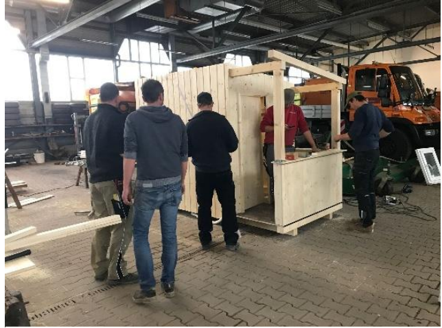
Der Bauwagen entsteht
